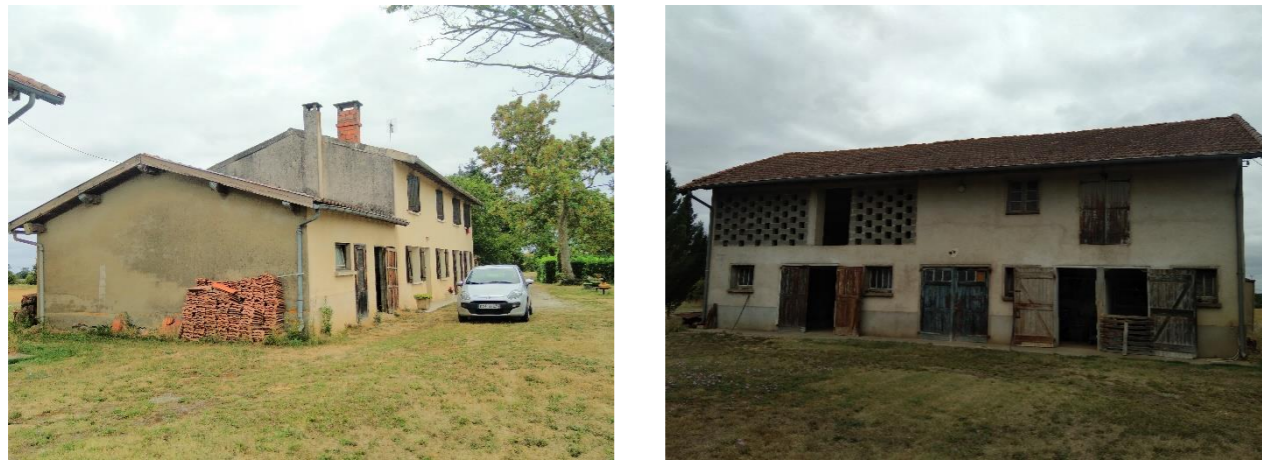
Figure 35 : Bâtisse principale et grange attenante (ferme « Belpelou »)
